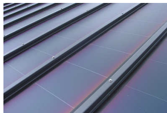
Darstellung 9: Amorphe Silizium-Solarzelle.
