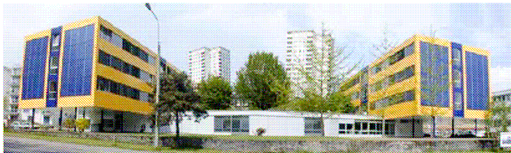
Darstellung 29: Integrierte Solarzelle in einem Gebäude.
