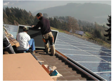
Montage der PV Anlage
