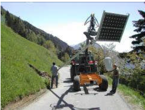
Montage der Solarlampen
